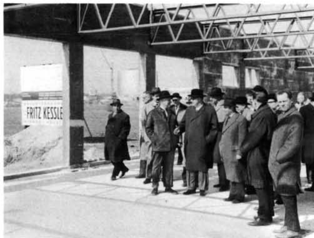
El Canciller Federal de Austria, Dr. Julius Raab (en el centro) visitando las obras de construcción del Laboratorio del OIEA en Seibersdorf, cerca de Viena, a la terminación de una etapa de las mismas. Aparece conversando con el Director General, Sr. Sterling Cole; a su izquierda el Dr. Henry Seligman, Director General Adjunto de Investigaciones e Isótopos
