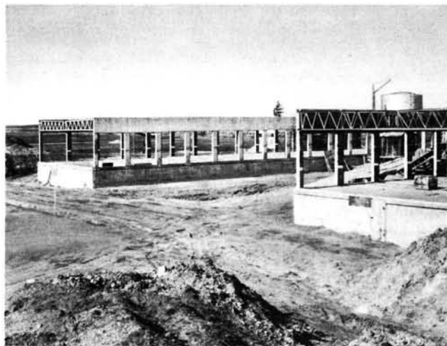
Laboratoire de l'Agence en construction à Seibersdorf, près de Vienne
