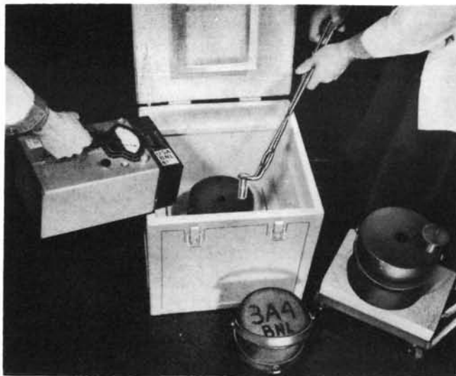
Aplicación de normas de seguridad en los Estados Unidos. En la foto aparece una muestra radiactiva, lista para su envío, en el momento de ser depositada en un recipiente de plomo colocado en una caja de madera, a fin de asegurar la protección contra las radiaciones prevista en la reglamentación de la Comisión de Comercio Interestatal. Como medida de precaución para el personal, la radiactividad se mide con un dosímetro
