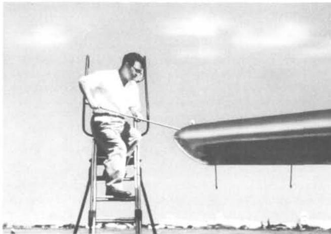
M. J.D. Pearson, expert de l'assistance technique de l'Agence, retire un envoi de radiosodium et de radiopotassium de l'aile d'un avion à l'aéroport de Bangkok. Les envois radioactifs sont transportés en bout d'aile afin que les radioisotopes n'exposent pas les personnes à bord de l'avion à un risque d'irradiation. Les radioisotopes contenus dans cet envoi permettront à des médecins thaïlandais d'étudier des cas de choléra
