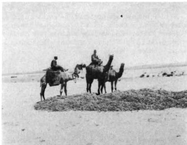
Materiales para los cimientos y paredes de hormigón del edificio en que se instalará la fuente de cobalto-60, transportados mediante camellos hasta el campo radiatorio de Inshas
