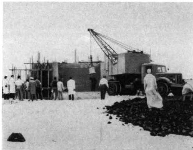
Instalación de la fuente de cobalto en el campo radiatorio
