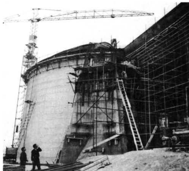
El Sr. W.C. Burch, experto de asistencia técnica del OIEA, ha prestado asesoramiento para la construcción del reactor de investigación de la Universidad de Teherán (Irán). En la fotografía, tomada en el mes de abril último, se puede apreciar el adelanto de las obras
