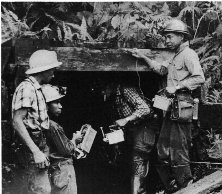
En la boca de una antigua mina en Filipinas. Un experto del OIEA instruye a un grupo de geólogos de la Dirección de Minas de Filipinas en el empleo de contadores Geiger antes de entrar en el túnel para comprobar la presencia de materiales radiactivos.
