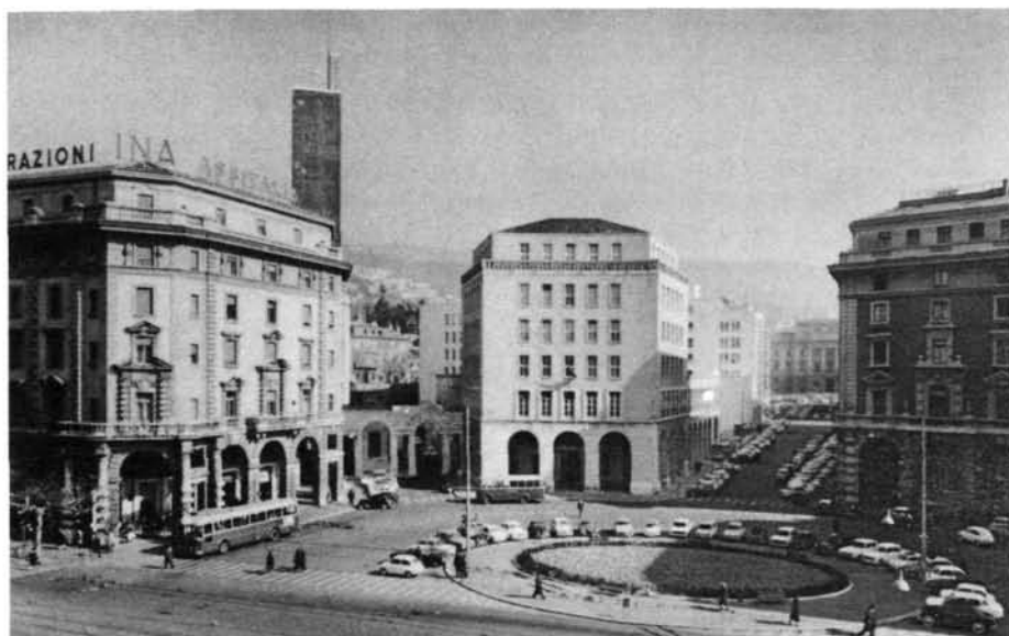
Siège provisoire du Centre de Trieste, place Oberdan (au centre de la photo).
