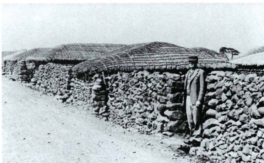
Maisons construites avec les pierres provenant du déblaiement du terrain sur lequel elles sont bâties. Leurs toits de chaume sont arrimés par des cordes pour éviter que le vent ne les emporte. (Photo: Chang Kun Lee)
