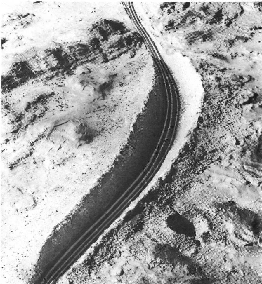
Aspecto que tendría una excavación en terreno montañoso, practicada con explosivos nucleares, para construir una vía férrea y una carretera. La foto ilustra los resultados de un estudio de viabilidad técnica realizado en los Estados Unidos. (Foto: Lawrence Radiation Laboratory)
