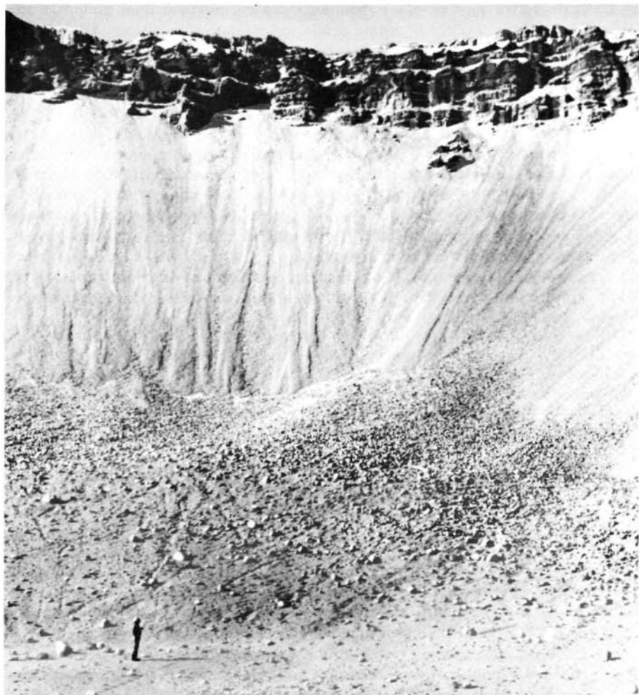
Intérieur d'un cratère creusé dans le Nevada (Etats-Unis) au cours de l'opération "Sedan" visant à réunir une documentation sur l'emploi des explosifs nucléaires pour des travaux de terrassement. Un engin thermonucléaire de 100 kilotonnes (équivalent à 100 000 tonnes de TNT) a permis d'obtenir un cratère de 352 mètres de largeur et 97 mètres de profondeur, présentant des rebords de 6 à 30 mètres de haut. Sept mois après l'explosion, la radioactivité avait suffisamment décru pour ne plus exiger de vêtements de protection. (Photo: Lawrence Radiation Laboratory)
