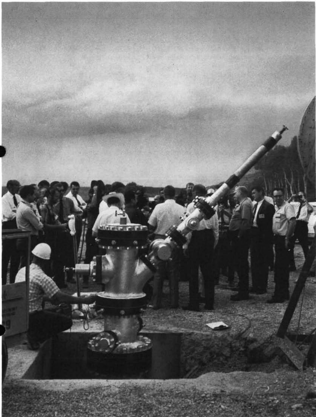
... y después. En esta fotografía, tomada en el punto cero poco después de detonar el ingenio de Rulison, puede verse a los observadores recibiendo instrucciones. El técnico (con casco protector) controla la boca del pozo, cerrada herméticamente, para detectar eventuales escapes de radiactividad: no hubo ninguno.
