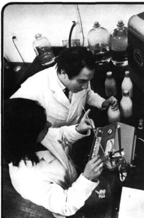
Dans un laboratoire chilien d'hygiène industrielle un chimiste fait l'analyse radiochimique du lait pour déceler la présence éventuelle du strontium 90. Photo: OMS, P. Larsen.
