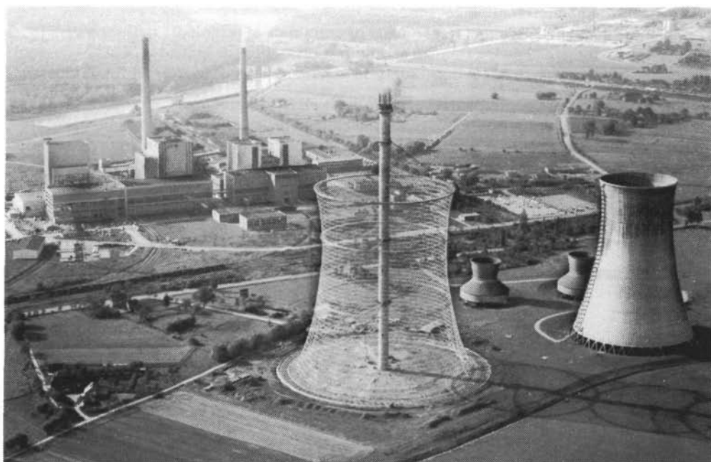
El reactor de torio de alta temperatura en construcción en Uentrup (República Federal de Alemania) está relacionado con las centrales nucleares a base de combustibles fósiles actualmente en funcionamiento. En primer plano, una torre de desactivación seca en fase de construcción. Foto: VEW
