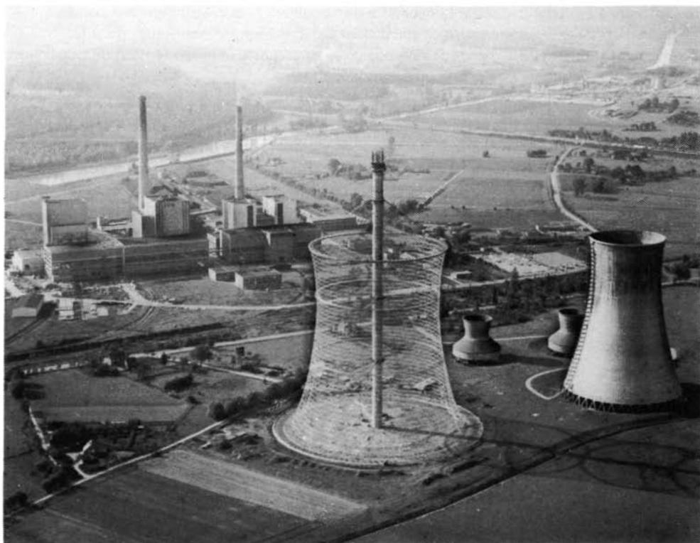
Le réacteur à haute température au thorium en construction à Uentrup (R.F.A) est relié à des centrales thermiques en service. Au premier plan, une tour de refroidissement en construction. Photo: VEW
