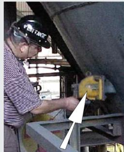
A carcaça de um medidor de nível com fonte gama incorporada. O detector está no lado oposto do silo.
