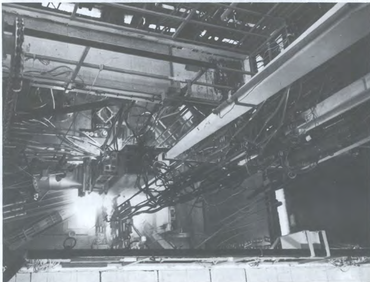
Рис. 3. Вид на бассейн реактора Осирис: отчетлива видна внутренняя часть реактора. Активная зона расположена внутри основного канала теплоносителя реактора. (Фотография любезно предоставлена Комиссариатом по атомной энергии).
