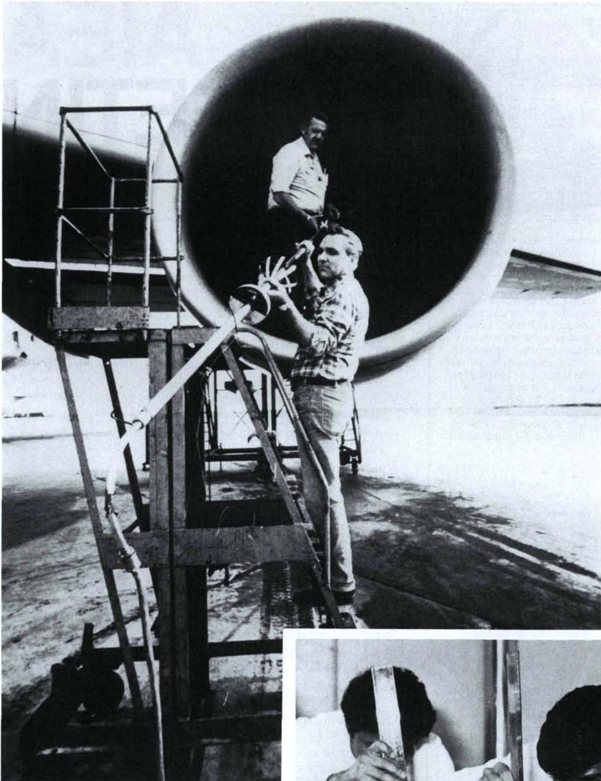
Parmi les applications courantes des radio-nucléides communément transportés figurent la recherche agronomique et le contrôle de la qualité dans l'industrie aéronautique et la construction mécanique. Sur notre photo ci-dessus, vérification à l'aide d'un appareil de gammagraphie de l'intérieur d'un réacteur d'avion de ligne. (Photos Tech/Ops)
