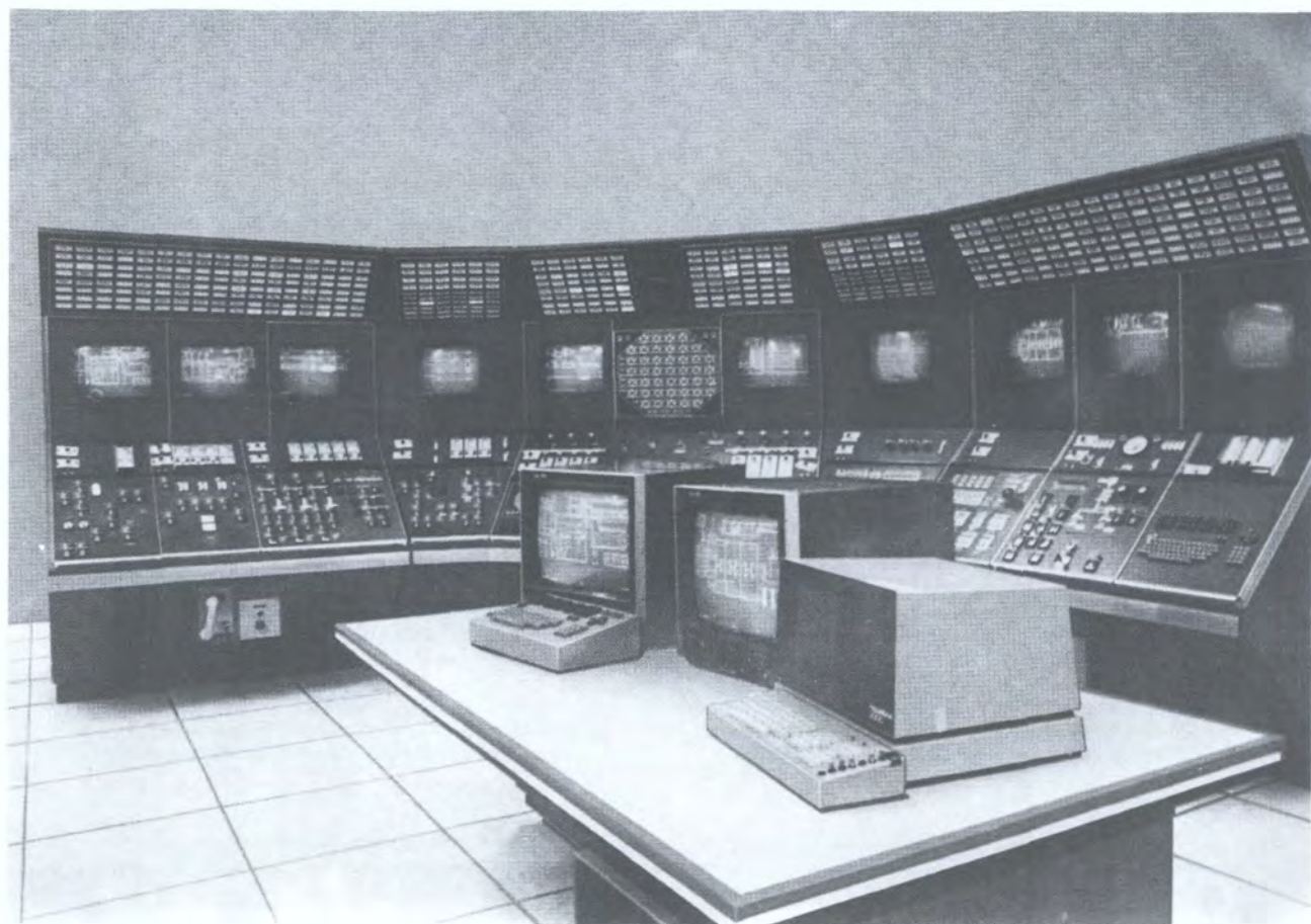
Тренажеры представляют собой подлинные модели конкретного блочного щита управления. На фото показаны системы для АЭС Саскуэханна, США (вверху) и для АЭС Брюс-Б с реакторами типа КАНДУ фирмы Онтарิโอ хайдро, Канада. (Предоставлены: верхнее фото — Link SSD; нижнее фото — CAE Electronics Ltd.)
