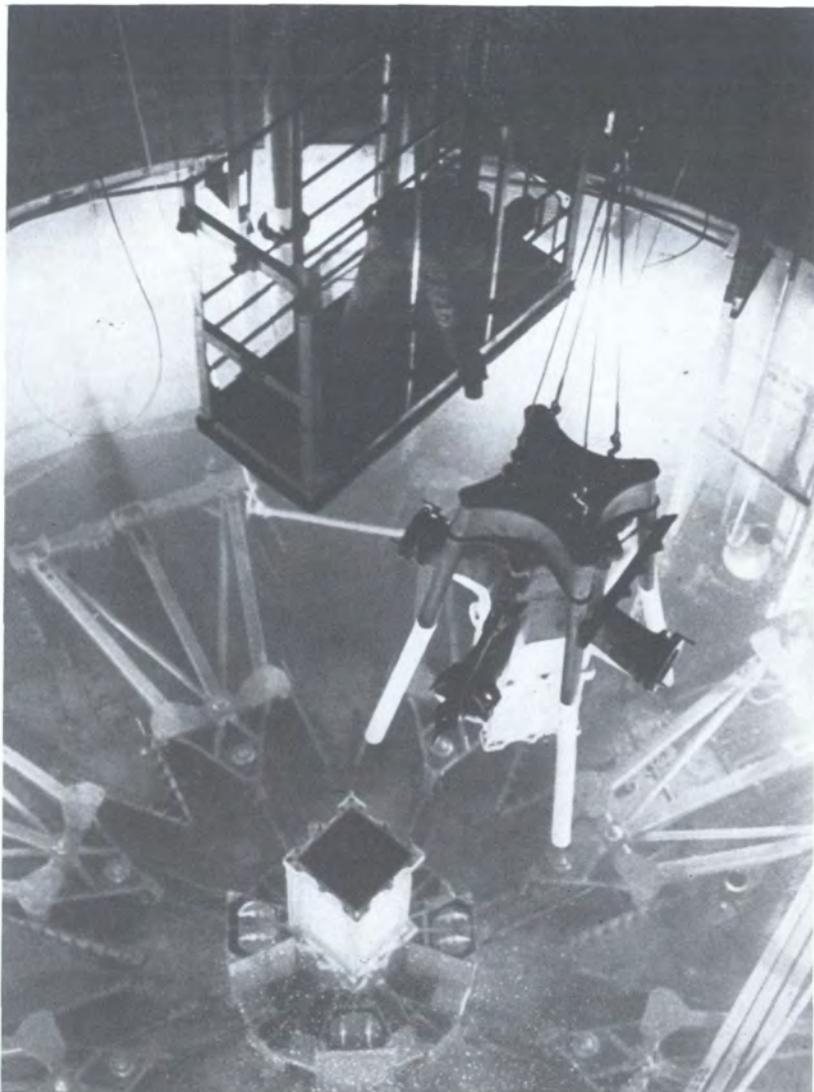
Операции по демонтажу в активной зоне исследовательского реактора (Пегас во Франции). Снятие с эксплуатации реактора было доведено до 3-го этапа в 1978 г. (Предоставлено: КАЗ Франции)
