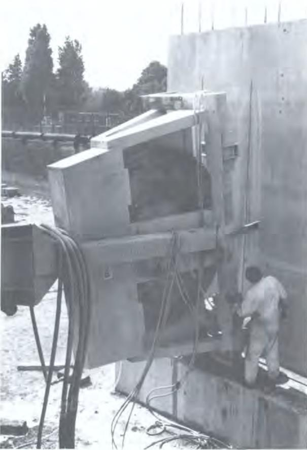
Эта циркулярная пила с алмазной режущей частью была разработана и испытана при демонтаже толстых бетонных конструкций АЭС. (Предоставлено: Министерство энергетики Великобритании.)
