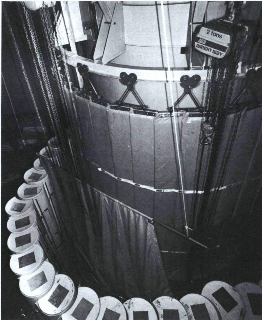
En julio de 1984 la cabeza de la vasija del reactor dañado en TMI-2 fue colocada en su lugar de almacenamiento en el edificio del reactor. La cabeza de la vasija está envuelta en mantas de plomo y rodeada de columnas rellenas de arena que le sirven de blindaje.
