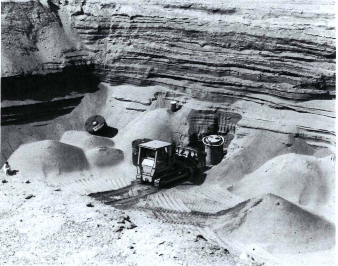
Un conteneur «inaltérable», muni d'un préfiltre EPICOR II, est enfoui sur le site du Service écologique des Etats-Unis pour l'évacuation des déchets de faible radioactivité.
