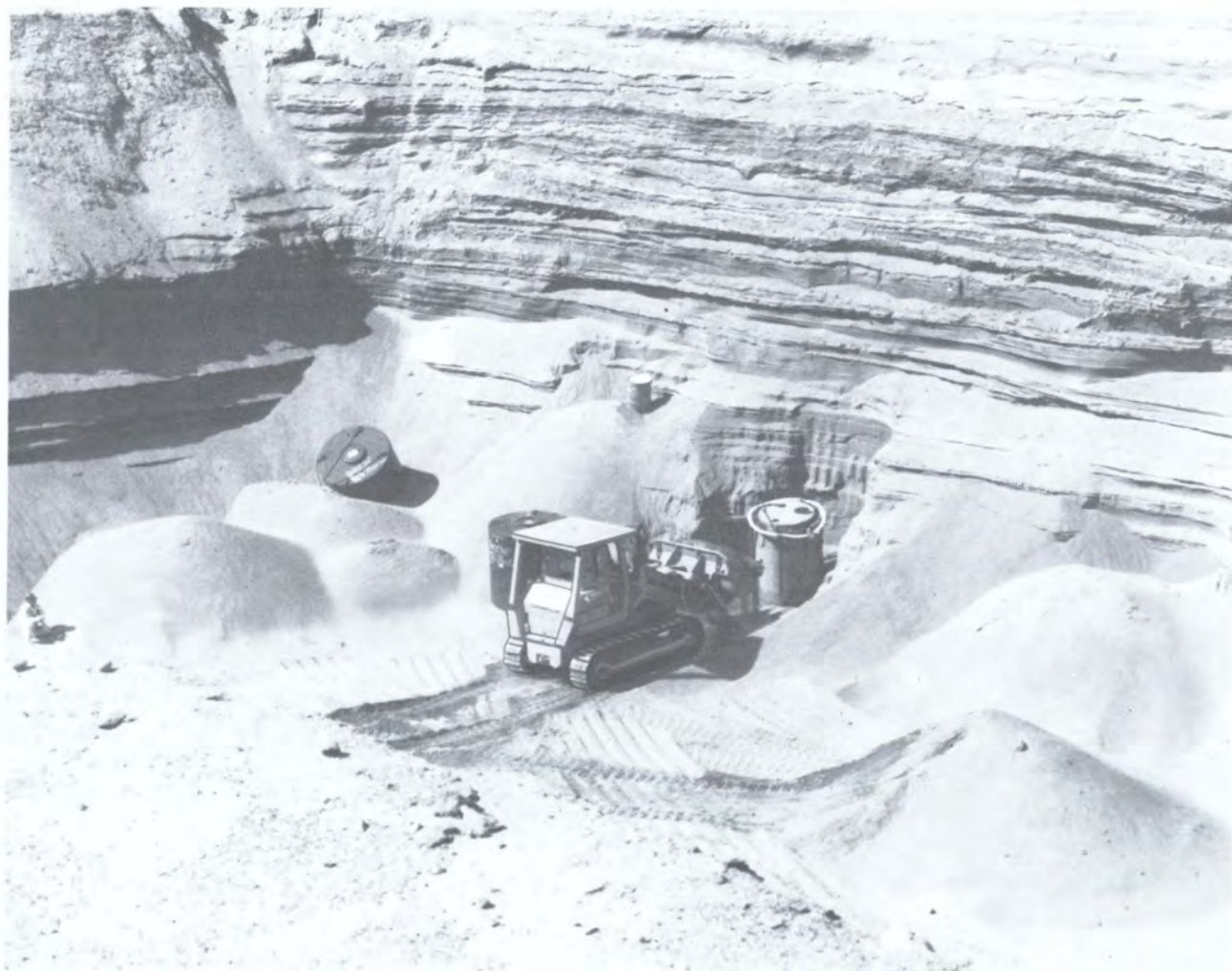
Захоронение демонстрационного контейнера „высокой целостности“, содержащего предварительный фильтр EPICOR-II, на экологической площадке США для низкоактивных отходов.
