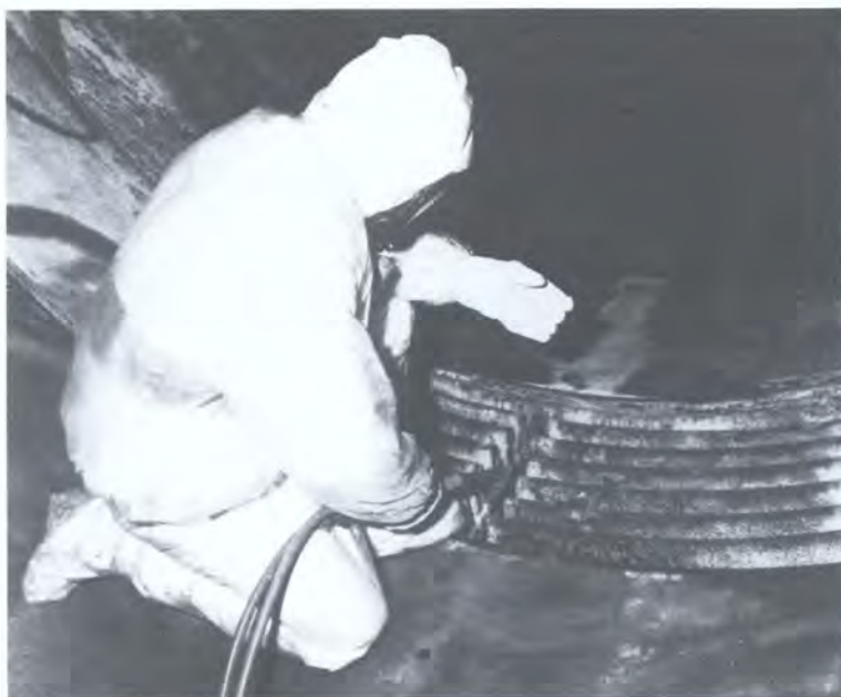
Резка первичного контура установки G-1 в Маркуле, которая была закрыта в 1975 г. и будет сниматься с эксплуатации в 1986 г. (Предоставлено: КАЭ Франции.)
