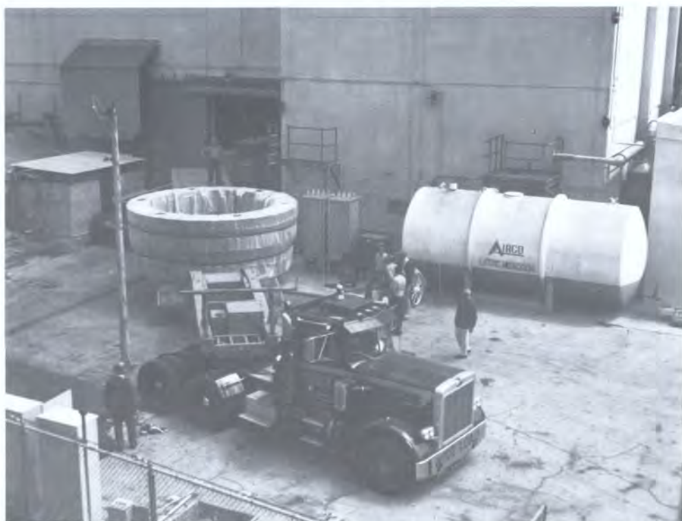
Часть реактора SRE в Калифорнии отправляется на захоронение. SRE был демонтирован в 1982 г. (Предоставлено: Rockwell International)
