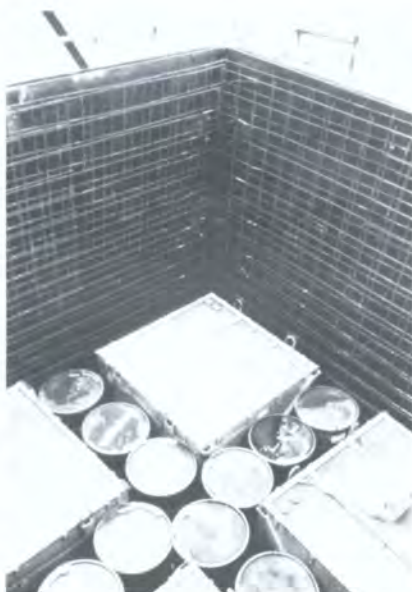
Нижний слой монолита на площадке для захоронения отходов в Ла Манш: усиленные стенки и место для заливки бетонного раствора.
