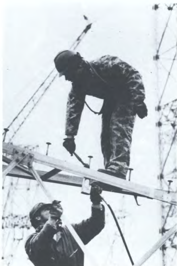
Рабочие на линиях электропередачи (фото EPRI)
