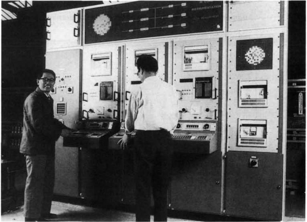
Tableau de commande de l'instrumentation en pile de la centrale nucléaire de 300 MWe en construction à Qinshan (Chine). (Photo: Framatome)
