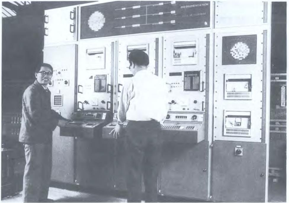
中国正在建造的 300MWe 秦山核电厂的堆芯测试设备 (来源: 法马通公司)。
