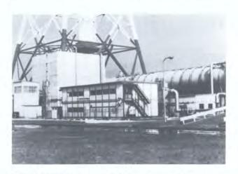
Данная опытная установка в Японии использует радиацию для обработки отработанных газов из сталеплавильной агломерационной печи Исследовательской ассоциации по уменьшению содержания и удалению NO<sub>X</sub> в сталеплавильной промышленности
