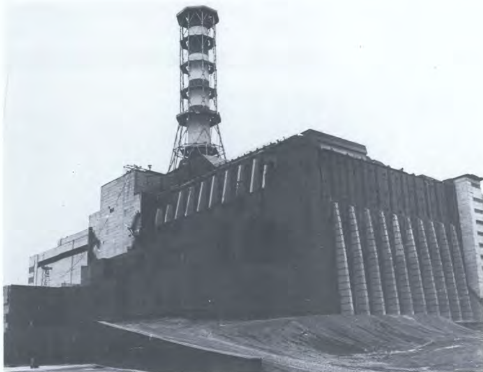
为了封住放射性物质和防止污染环境，被毁的切尔诺贝利核电厂4号反应堆已被封装在称为“封套”（一般称为“石棺”）的构筑物中。
