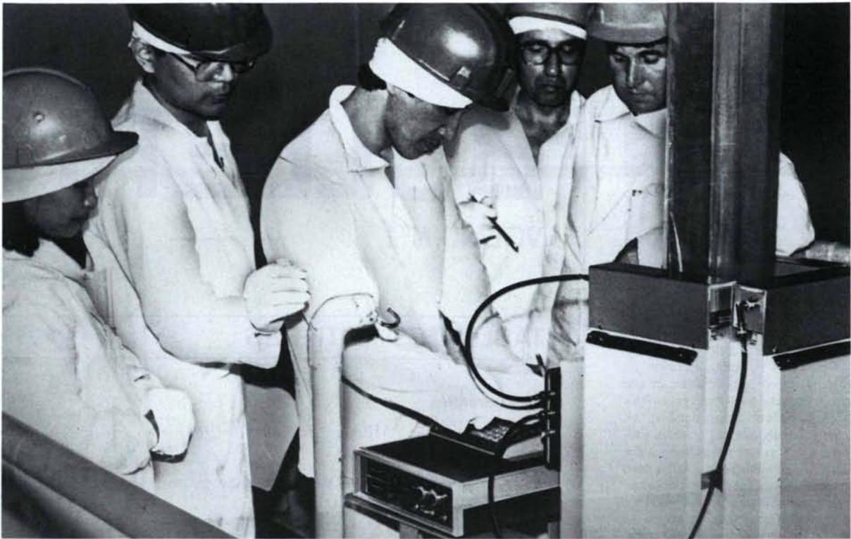
▲ Pendant un exercice d'inspection en URSS, un inspecteur de l'AIEA et ses nouveaux collègues mesurent la teneur en uranium du combustible neuf pour réacteur VVER-400 à l'aide d'un compteur de neutrons à coïncidence. (Photo: Comité d'Etat de l'URSS pour l'utilisation de l'énergie atomique)
