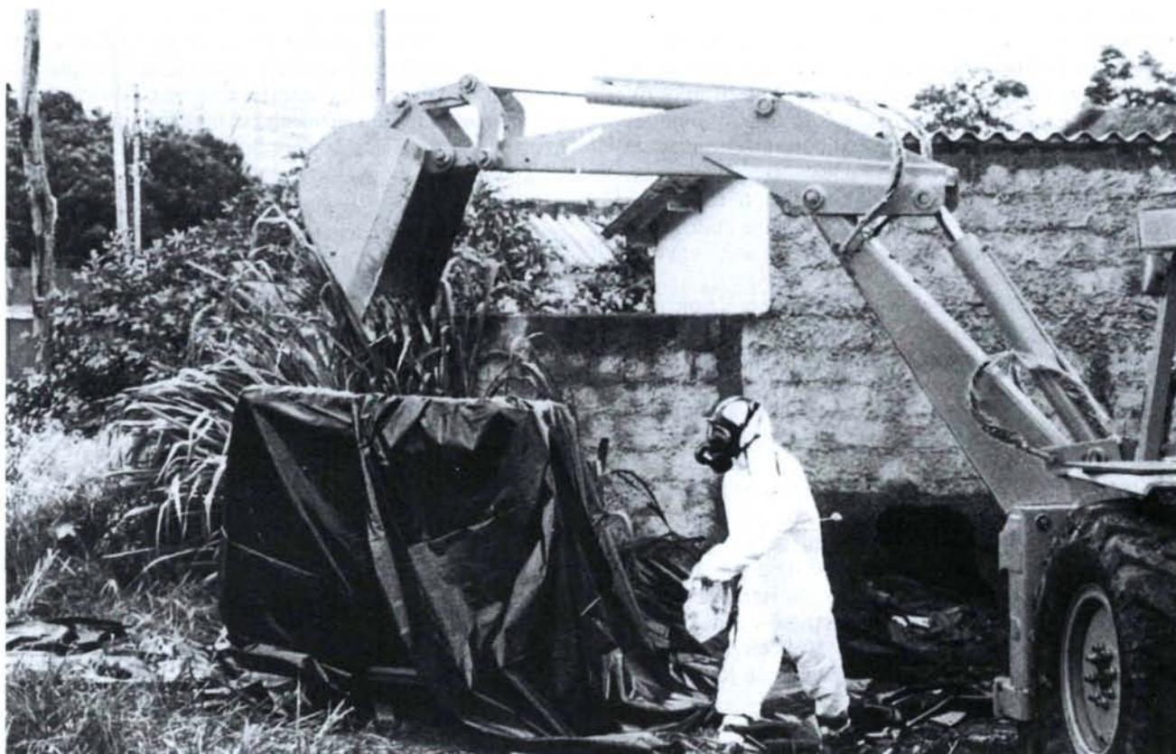
Pendant l'opération de décontamination, un excavateur est utilisé pour éliminer un point chaud avant de procéder à la démolition de la maison. (Photo: CNEN)
