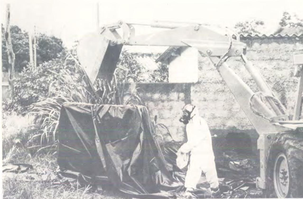
В рамках работ по дезактивации экскаватор удаляет из дома перед его разрушением радиационную „горячую точку“.
