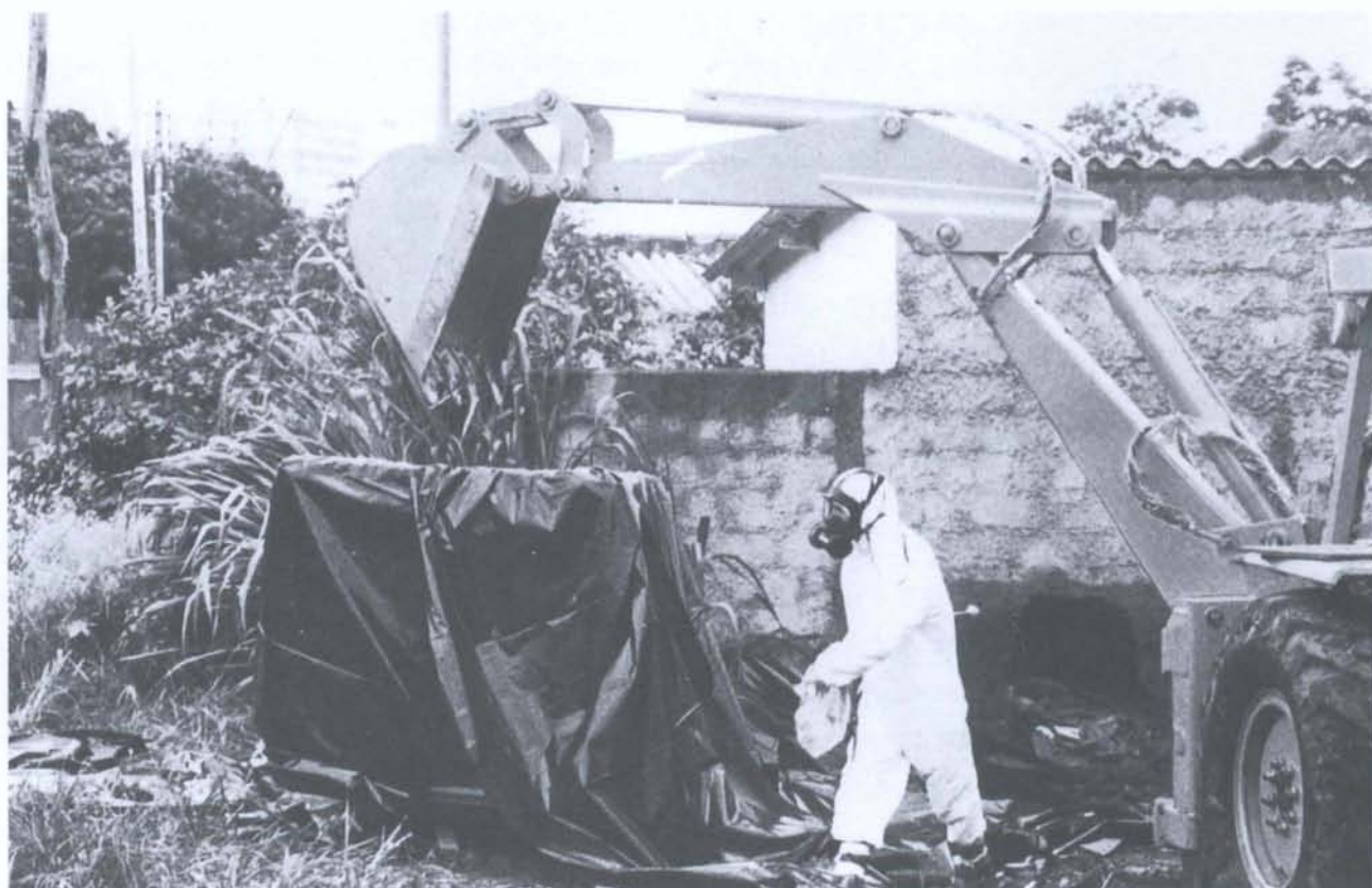
除染作業の一貫として、家屋を撤去する前に、家屋の放射線の「ホットスポット」を、掘さく器で除いた（提供：CNEN）。
