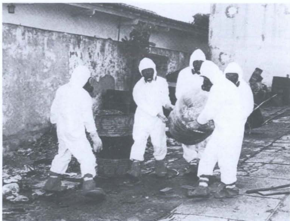
撤去された汚染物質など（提供：CNEN）
