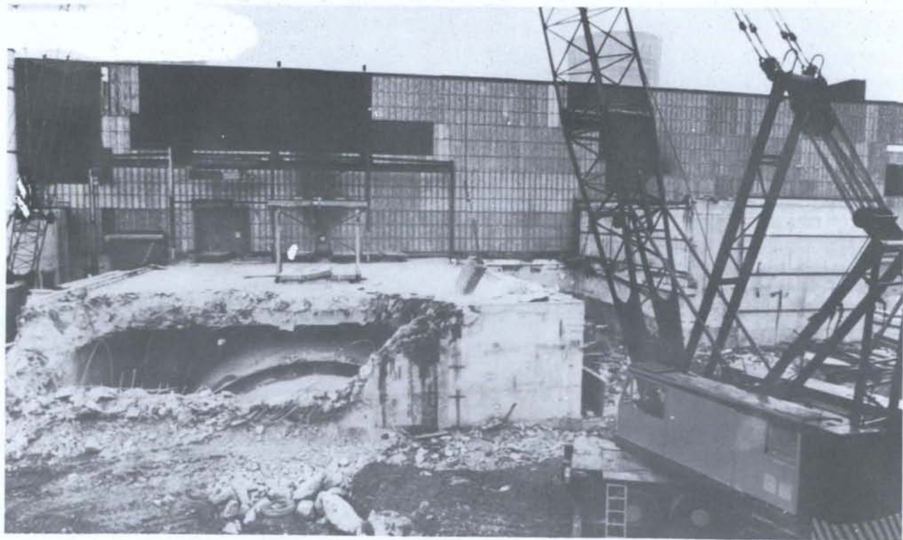
美国拆除施平港核电厂现场。（来源：US DOE）
