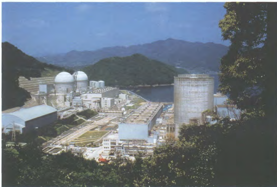
Современная коммерческая ядерная промышленность производит около 17% мирового объема электроэнергии. Вверху: Помещение пульта управления перерабатывающего предприятия в Селлафилде, Соединенное Королевство. Внизу: Атомная станция в Такахаме, Япония. (Фото: BNFL, JAIF)
