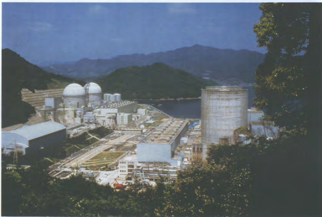
今天,商用核工业提供的电力占世界总发电量的 17%。上图:英国塞拉菲尔德后处理厂控制室。左图:日本高滨核电厂。(来源:BN-FL,JAIF)
