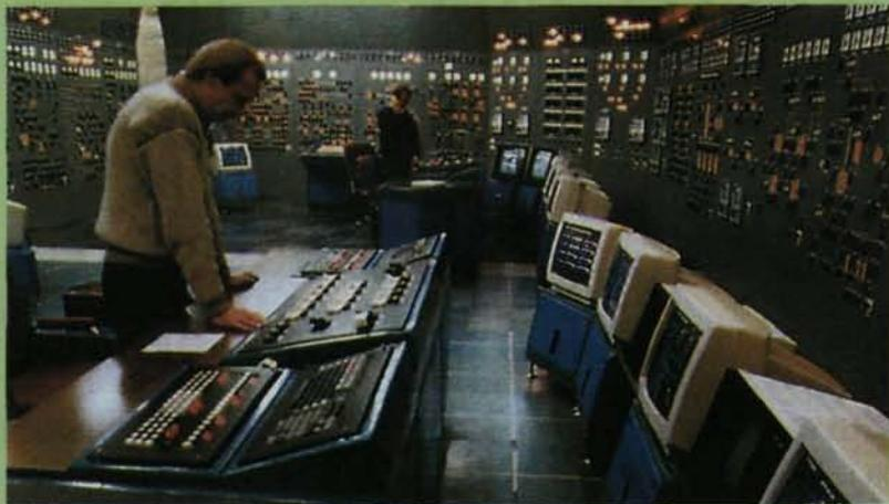
En el centro de capacitación de Balakovo, Rusia, se usa un simulador de tamaño natural para capacitar a los explotadores de centrales nucleares. Cortesía: Departamento de Energía de los EE.UU.
