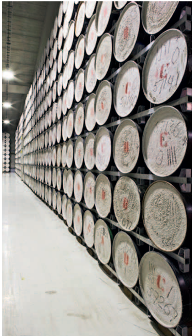
مرفق لخن النفايات الضعيفة الإشعاع على المدى الطويل (مصدر الصورة: الهيئة المركزية للنفايات المشعة، هولندا)
