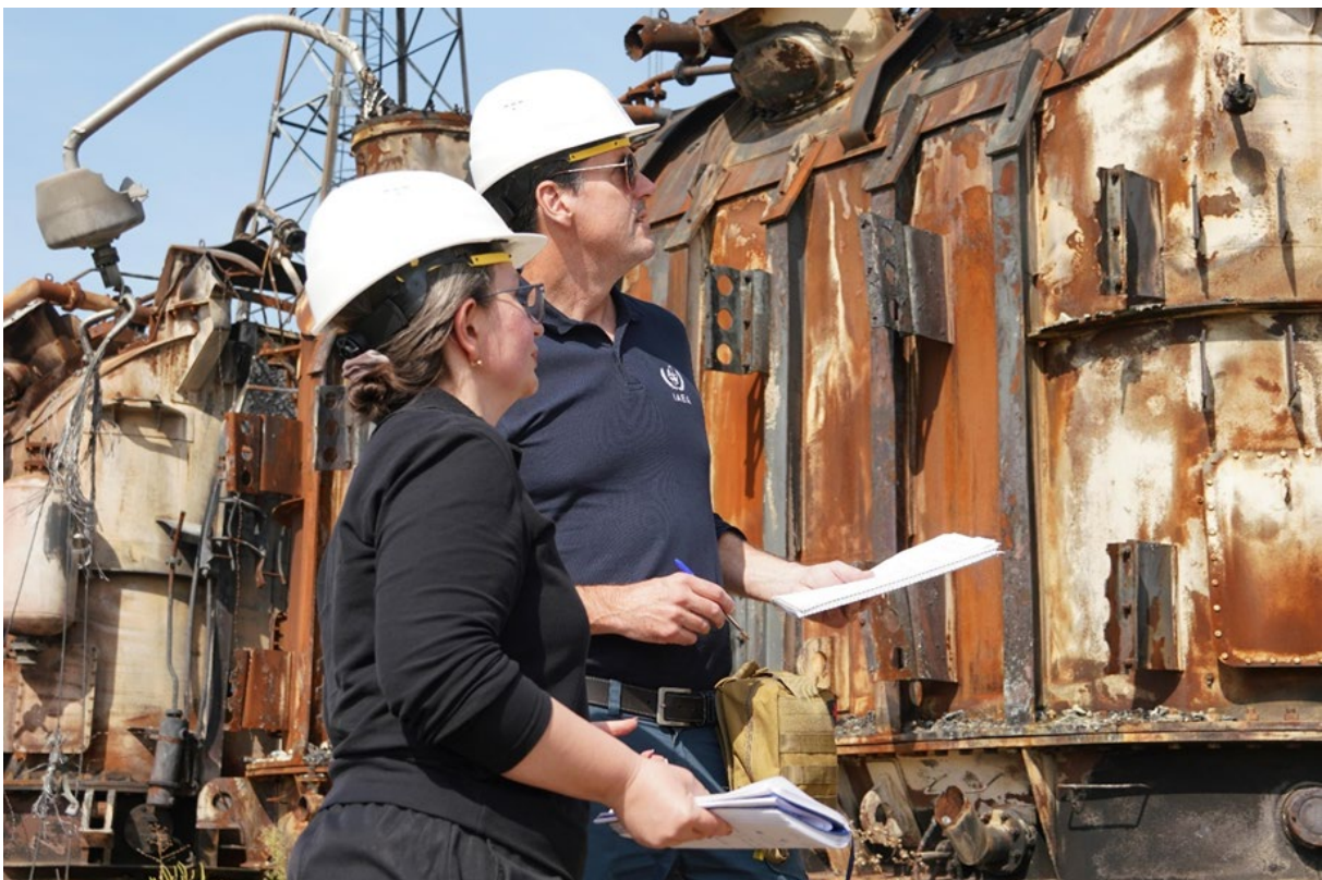
原子能机构工作人员于 2024 年 9 月 12 日视察基辅变电站。
