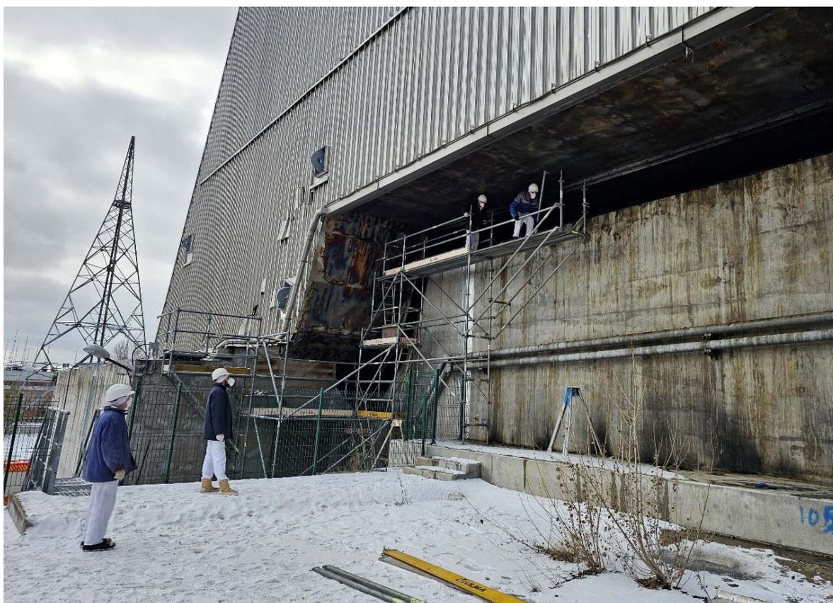
2025年2月20日，有关人员视察新安全封隔设施拱形轮廓和混凝土支撑结构之间的薄膜损坏情况。
