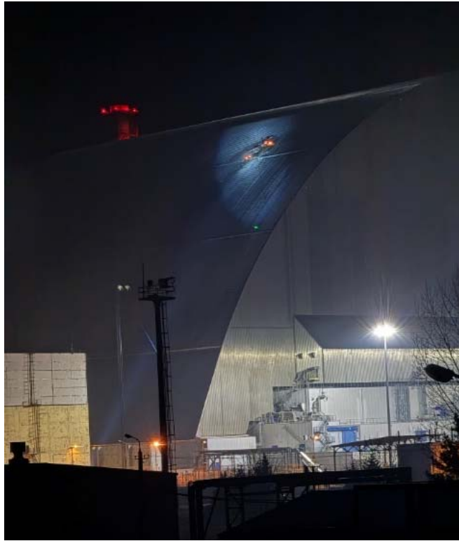
Пожар на НБК, наблюдавшийся вскоре после удара БПЛА, нанесенного по сооружению 14 февраля 2025 года.
