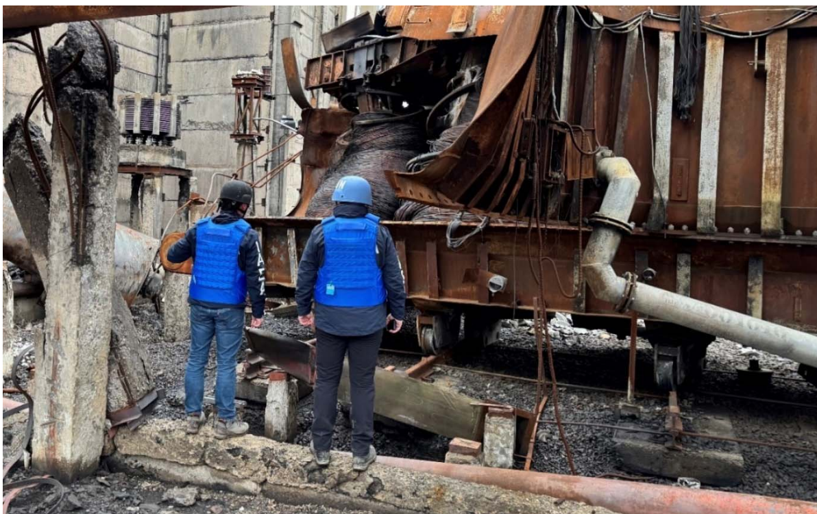
Сотрудники Агентства осматривают одну из критически важных подстанций Украины для оценки повреждения и его влияния на ядерную безопасность АЭС, декабрь 2024 года (фото: НЭК «Укрэнерго»).
