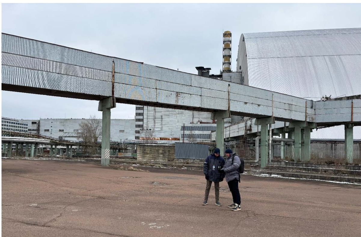
ИСАМИЧ ведет радиационный мониторинг на площадке ЧАЭС 7 февраля 2025 года (фото: ЧАЭС).
