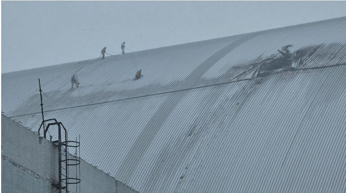
*El personal de respuesta escala el Nuevo Confinamiento Seguro el 14 de febrero de 2025 como parte de las labores encaminadas a evitar que las llamas se propaguen por el plaqueado externo e interno.*
