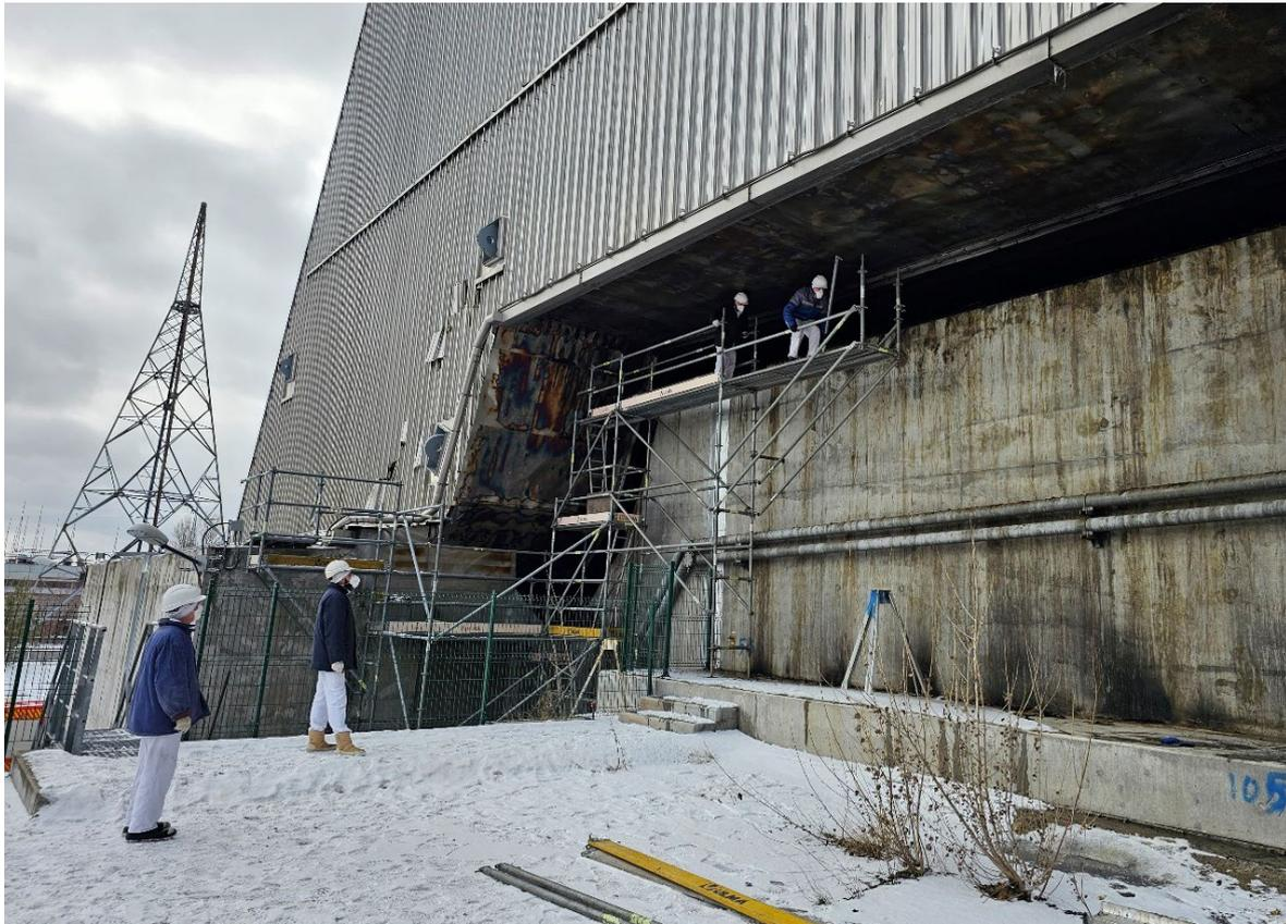
*El personal inspecciona los daños en la membrana que se encuentra entre el borde del arco y la estructura de soporte de hormigón del Nuevo Confinamiento Seguro el 20 de febrero de 2025.*
