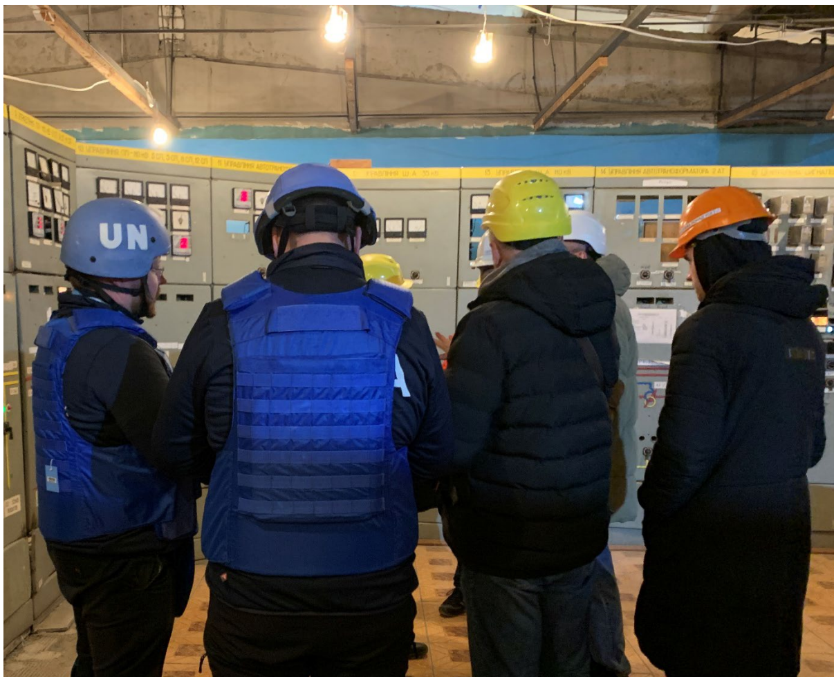
В ходе осмотра 25 февраля 2025 года диспетчерской одной из посещенных подстанций, сотрудники Агентства получили информацию о ходе восстановительных работ. (Фото: НЭК «Укрэнерго»)
