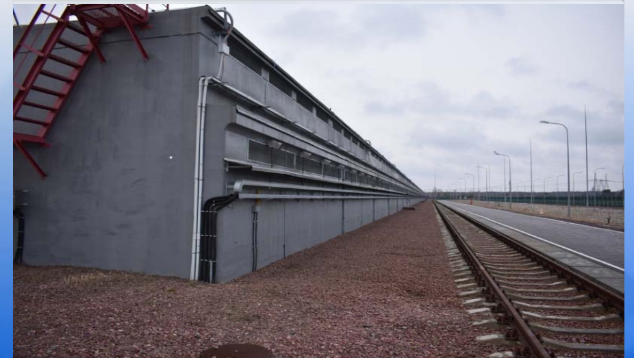
وحدات التخزين من الخرسانة لخزن الوقود النووي المستهلك في مرفق الخزن المؤقت-2
