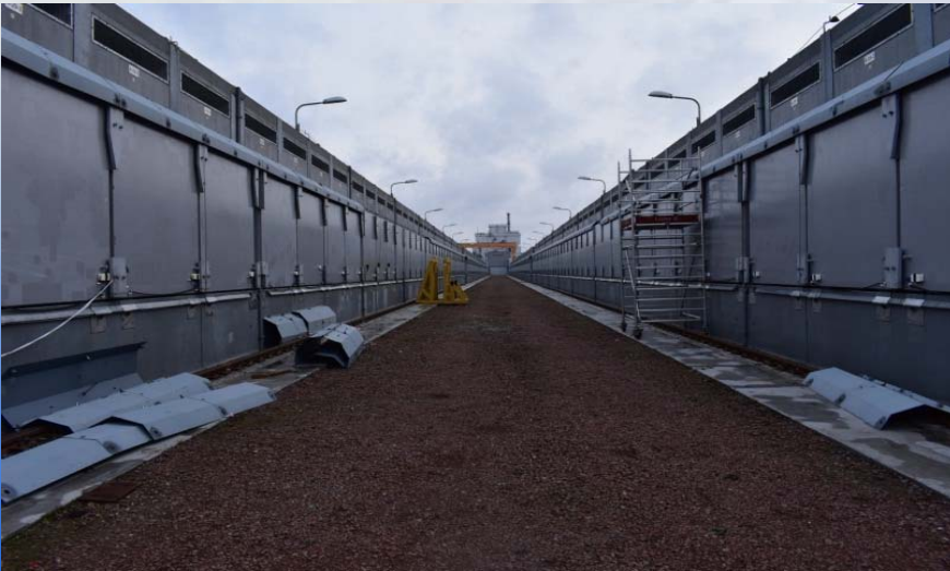
وحدات التخزين من الخرسانة لخزن الوقود النووي المستهلك في مرفق الخزن المؤقت-2
