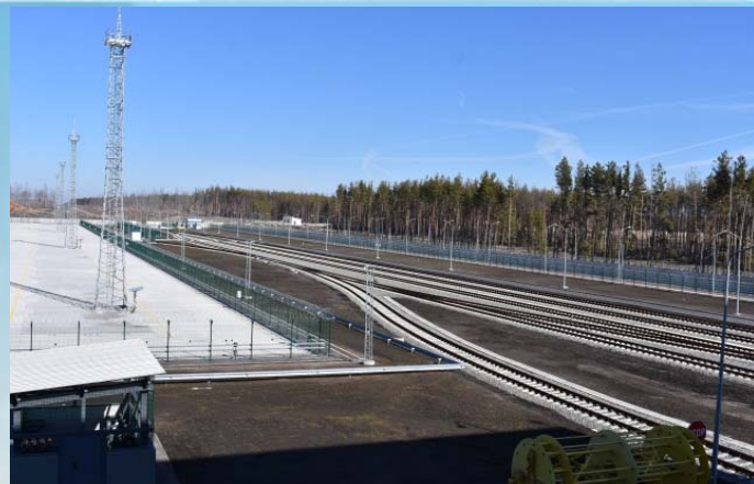
放射性废物运输铁路轨道
