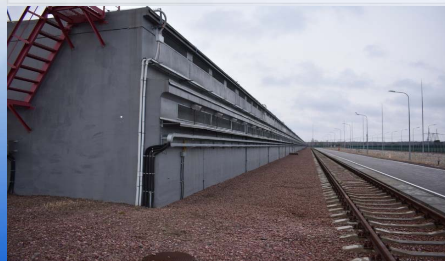
ISF-2的乏燃料混凝土贮存模块
