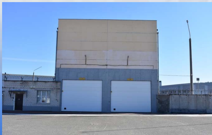
放射性废物操作大楼
