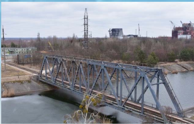
切尔诺贝利核电站铁路桥
