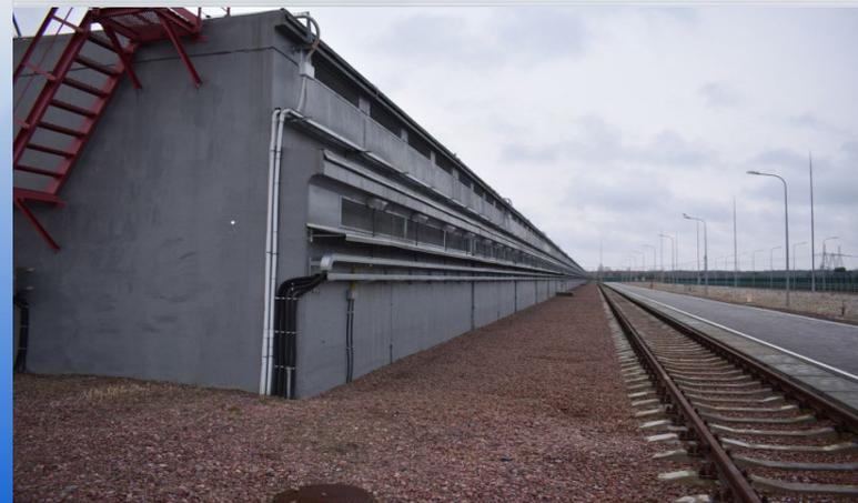
Modules d'entreposage en béton du combustible utilisé de l'ISF-2
