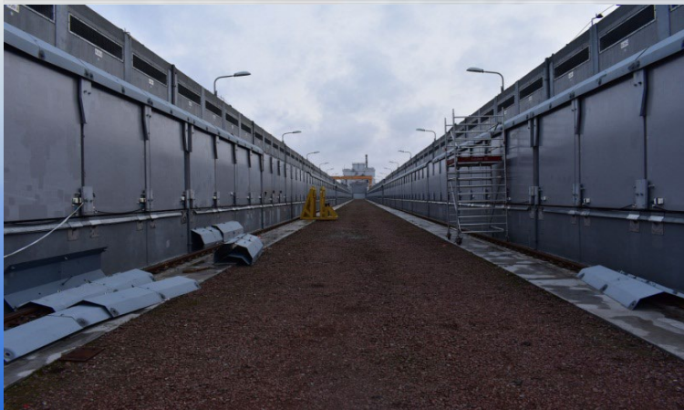
Бетонные модули хранения отработавшего ядерного топлива ХОЯТ-2
