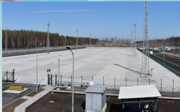
Площадка временного хранения радиоактивных отходов
