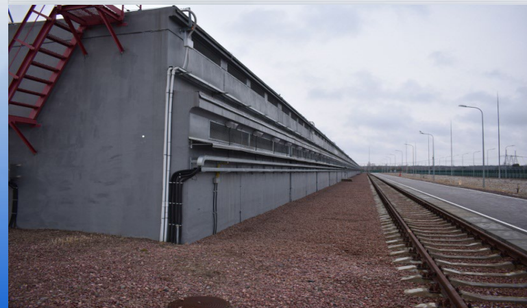
Бетонные модули хранения отработавшего ядерного топлива ХОЯТ-2
