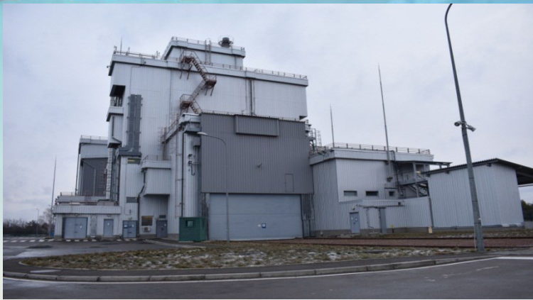
Здание перегрузки радиоактивных отходов
