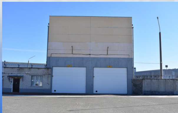
Здание перегрузки радиоактивных отходов
